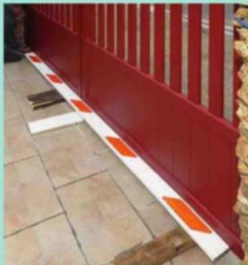
**7** Alignez les vantaux le long d'une règle, puis repérez les emplacements définitifs des crapaudines. Tracez également sur les faces des piliers les encastremements nécessaires aux pivots supérieurs.
