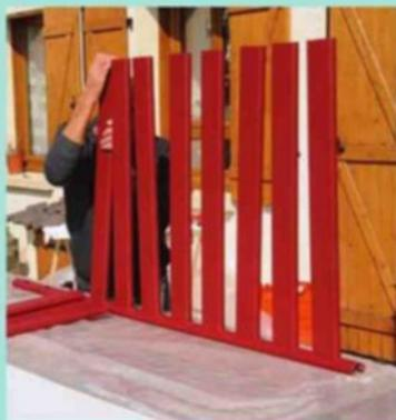
**3** Encastrez les barreaux (partie supérieure du battant) dans une traverse de barreaudage. Ajoutez à l'opposé l'autre traverse puis celle intermédiaire, frappez sur toute sa longueur. À l'aide de grands serre-joints, bridez l'ensemble avec le soubassement du portail, le temps de visser les montants.
