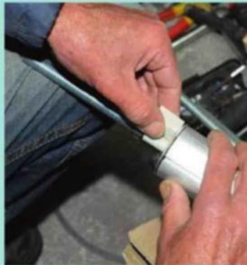
**14** Vissez la tige filetée du poteau. Avec de l'adhésif, repérez la longueur à fixer côté maçonnerie. Ôtez la tige et à l'aide de la travée, repérez l'emplacement du poteau sur le muret.
