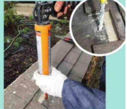
**15** Utilisez également de l'adhésif sur le foret pour matérialiser la profondeur de perçage. Percez le muret. Dépoussiérez le trou et garnissez-le de résine de fixation chimique.
