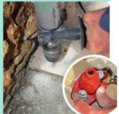
**8** Retirez le portail et percez les trous des fixations (goujons d'ancrage ou chevilles métalliques). Placez les crapaudines et vissez les écrous (ou vis), mais sans les bloquer.
