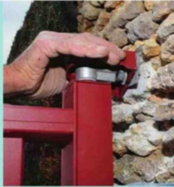
**11** Ne vissez pas le tirefond complètement pour pouvoir insérer la monture du gond par derrière. Sanglez à nouveau le vantail autour du pilier puis serrez la vis de retenue du gond.
