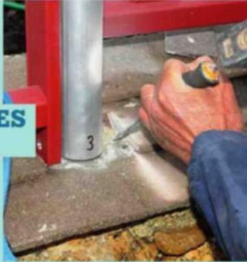
**18** Après séchage, vérifiez que les montants des travées s'installent sans forcer de part et d'autre du poteau. Si la découpe réalisée sur le muret ne suffit pas, rectifiez-la au burin.
