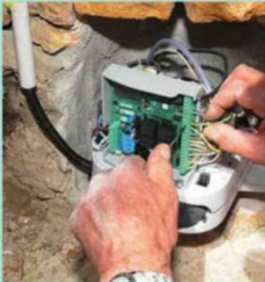
**28** Effectuez les raccordements électriques suivants : arrivée de l'alimentation sur le moteur 1, départ vers le 2, alimentation du feu clignotant et des cellules.
