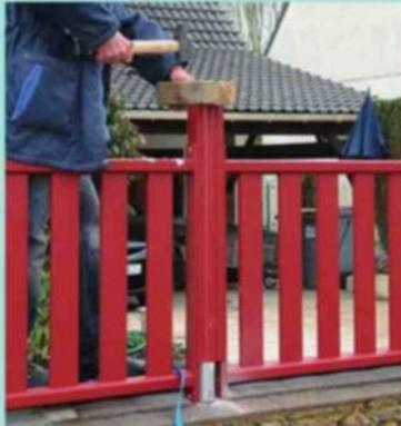
**20** Placez l'habillage au-dessus du poteau et engagez-le de part et d'autre sur les montants des travées. Faites-le descendre à fond à l'aide d'un marteau et d'une cale.
