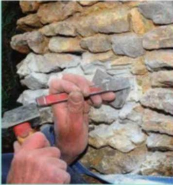
**10** Un gabarit en aluminium a été réalisé au profil du gond. Placez-le provisoirement pour évaluer les rectifications à effectuer au burin afin d'affiner la planéité du support.
