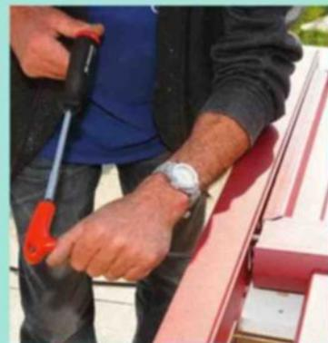
**4** Engagez les vis d'assemblage dans l'un des montants et présentez-le au bout des traverses. Engagez les vis dans les alvéoles des traverses et vissez-les.
