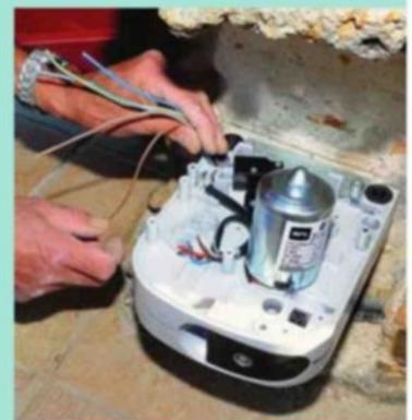
**25** L'alimentation étant réalisée à partir du premier moteur, faites-la cheminer jusqu'au second via un câble comportant le nombre de conducteurs requis (ici 5 x 1,5 mm<sup>2</sup>).
