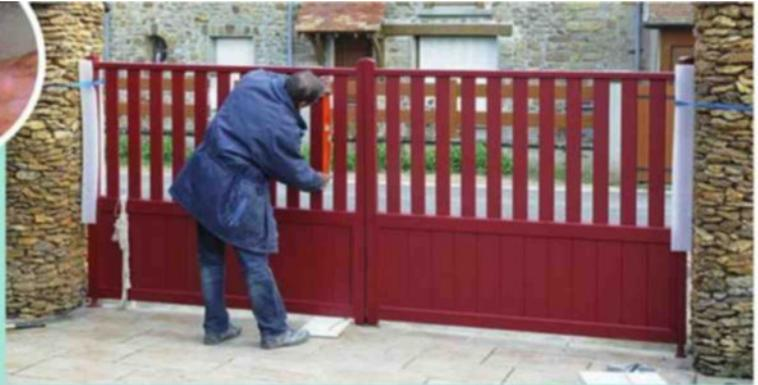
**6** Installez provisoirement les deux battants. Protégez les montants latéraux des vantaux et emboîtez-les sur leur crapaudine. Sanglez-les temporairement aux piliers. Vérifiez le jeu au battement (12 mm) et contrôlez les aplombs.
