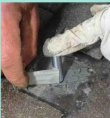
**16** Placez la tige jusqu'au repère. Essayez la résine qui reflue. Retirez l'adhésif, disposez la rondelle et vissez le poteau. Pour empêcher la tige filetée de tourner dans la résine, maintenez-la avec une pince.
