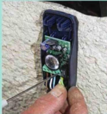
**29** Repérez la position des cellules : sur les faces internes des piliers (côté rue). Faites arriver le câblage jusqu'aux cellules et raccordez-les.
