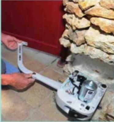
**26** Débrayez les moteurs et ajoutez les bras sans les bloquer. Déployez-les en respectant la flèche requise : 18 cm du pivot intermédiaire jusqu'au vantail fermé. Reportez les emplacements des chapes au dos des traverses. Puis bloquez les bras autour des axes des moteurs.
