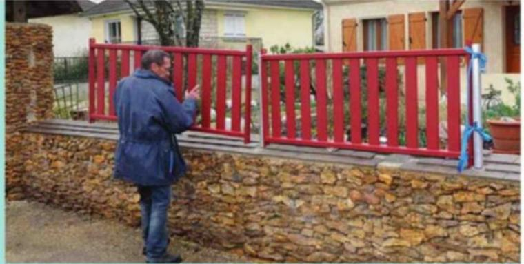
**19** Installez les travées deux par deux (ici livrées en trois sections de 1702 mm et deux sections de 1649 mm à assembler). Sanglez-les provisoirement sur l'un des poteaux en place. Maintenez-les avec des élastiques sur le poteau central, le temps d'enfiler son habillage.
