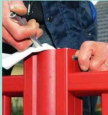
**21** Disposez un chiffon dans l'habillage. Ainsi aucun risque de perdre les écrous qui correspondent aux vis d'assemblage ; à bloquer ensuite avec une clé mâle.
