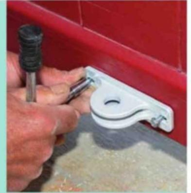
**27** Pointez et percez les trous dans les traverses basses des vantaux. Vissez-les avec les chapes et raccrochez les bras par leur pivot d'extrémité.
