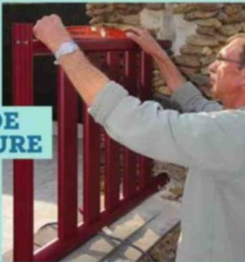
**13** Présentez la travée et contrôlez son aplomb dans les deux sens (gauche-droite et avant-arrière). Si besoin, rectifiez les logements dans le pilier au burin et à la massette.
