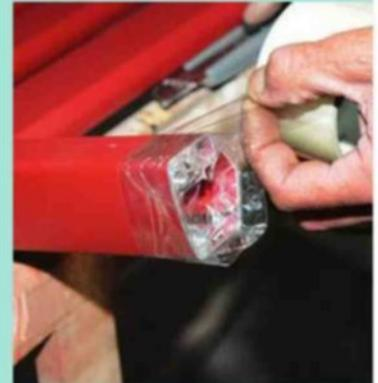
**22** Enrobez d'adhésif le bout des traverses des travées d'extrémité et engagez-les dans les piliers. Cela évite au mortier et à l'eau de gagner l'intérieur des profilés.
